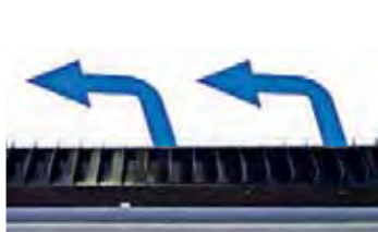
Направление воздушного потока в воздуховоде через вытяжную решетку.
