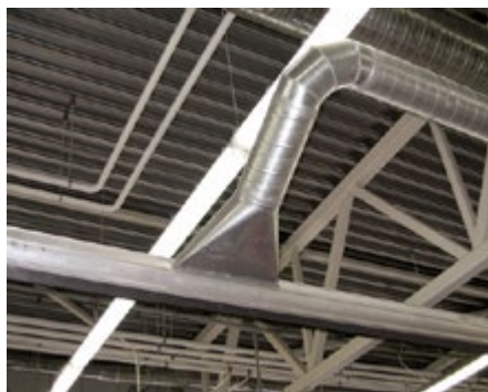
Подключение к вентилятору при помощи бокового коннектора sRRDC-200
