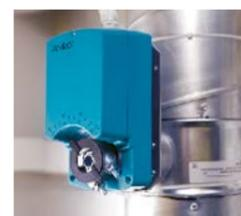
Автоматическая заслонка с электроприводом. Доступны диаметры 100, 125, 160, 200, 250, 315, 400. Питание электропривода и управление заслонкой осуществляется от пульта ICE-LC.
