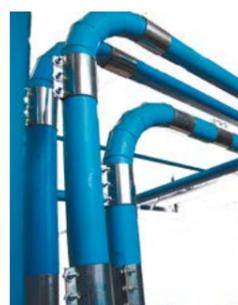
Сеть вакуумных трубопроводов прокладывается по существующим строительным конструкциям производственного помещения. Быстроразъемная конструкция трубопровода позволяет в короткое время демонтировать отдельные элементы для проведения регламентных работ.
