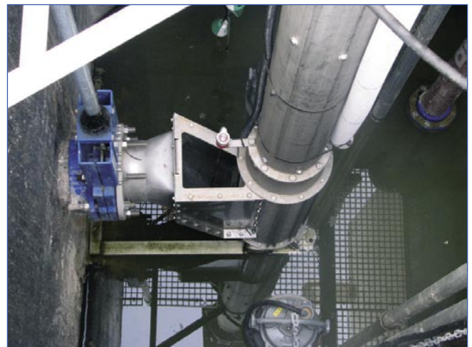
Waste water lifting system for protection of submersible pumps Abwasserhebestation zum Schutz der Tauchpumpen Station de relevage (protection de pompes immergées) Stazione di sollevamento acque reflue per la protezione delle pompe sommerse
